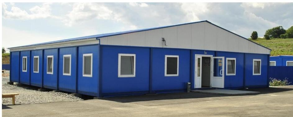
Рисунок 3.3 – Пример модульного мобильного здания
